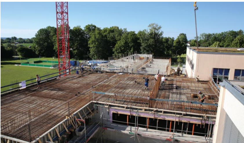
Die Bauphase - Momentaufnahme im Juni 2018.
