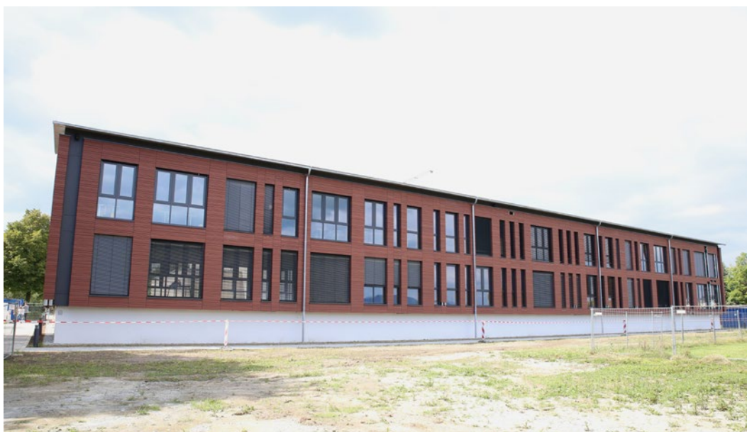
Der Gebäudetrakt Ost des St.-Gotthard-Gymnasiums.
