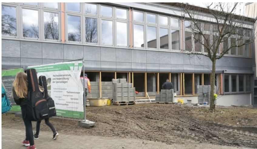
Die Bauphase - Momentaufnahme im März 2018.
